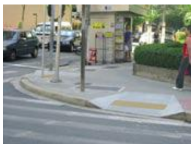
Рисунок 20 – Пример пандуса со скошенными боковыми гранями
