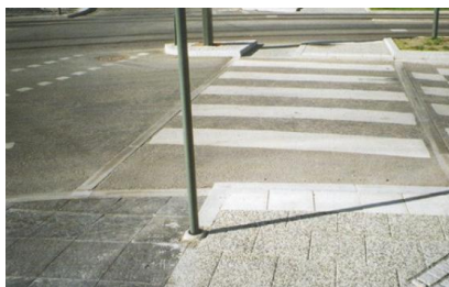
Рисунок 24 – Пример выполнения пандусов по краю пешеходного перехода
