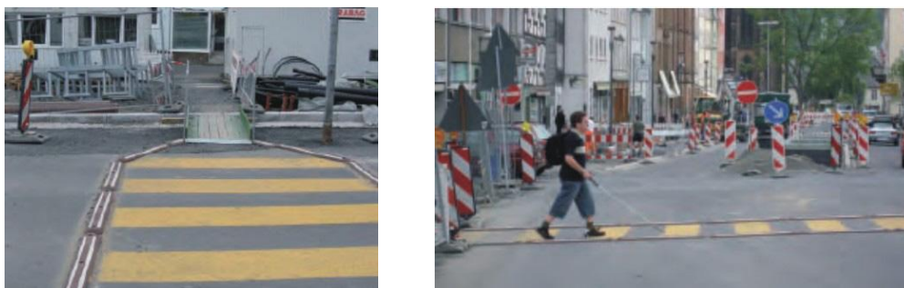
Рисунок 61 – Пример обустройства временного пешеходного перехода
