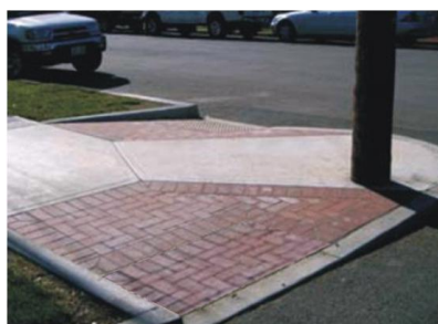
Рисунок 22 – Пример пандусов с бортиками
