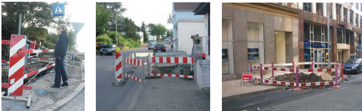
Рисунок 60 – Примеры обустройства мест проведения дорожных работ ограждениями, обеспечивающими безопасность движения инвалидов
