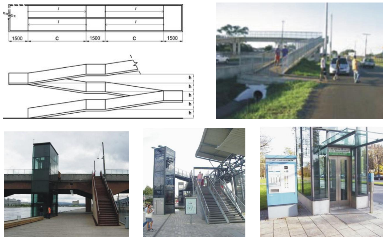
Рисунок 45 – Примеры пандусов и лифтов для инвалидов и других маломобильных групп населения на надземных пешеходных переходах
